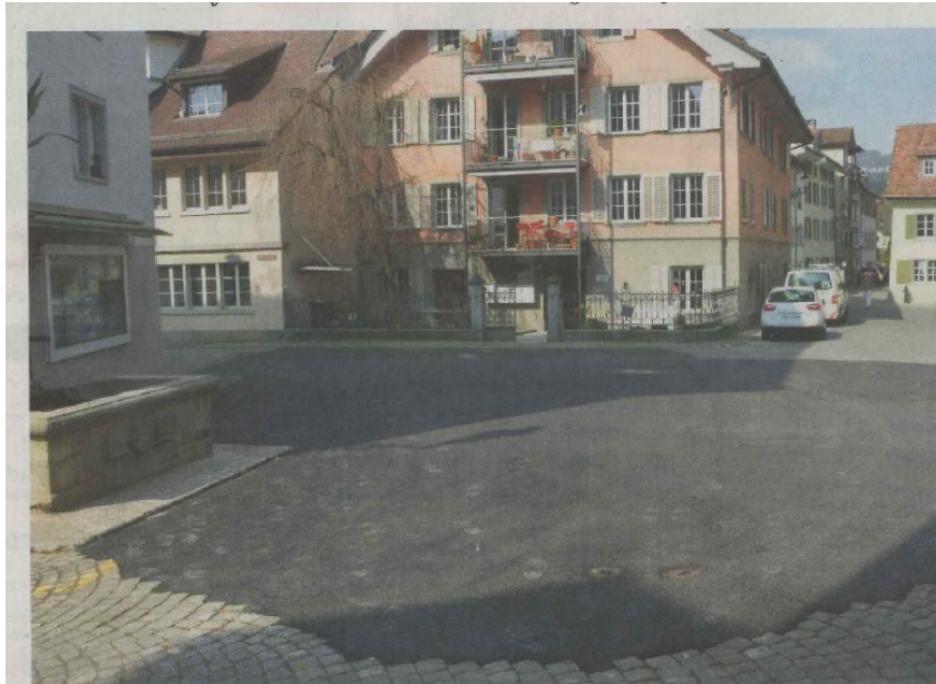
Abb. 1 Wasserrohrbruch am Stutzplatz (Bild: Bremgarter Bezirksanzeiger, s. Anhang 1)
