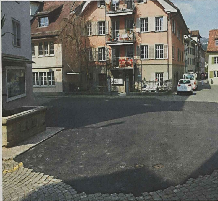
Der Wasserrohrbruch am Stutzplatz war mit Auslöser, dass der Stadtrat eine Gesamtsanierung der Werkleitungen Unterstadt beschlossen hat.
